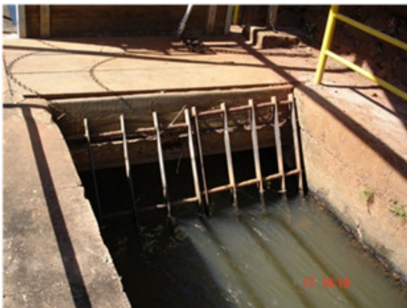
Foto 1.3 – Tomada d'água e grade de limpeza
