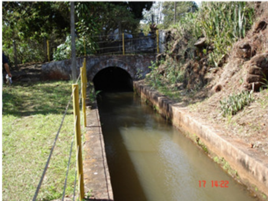
Foto 1.5 – Canal e túnel de adução - trecho de montante
