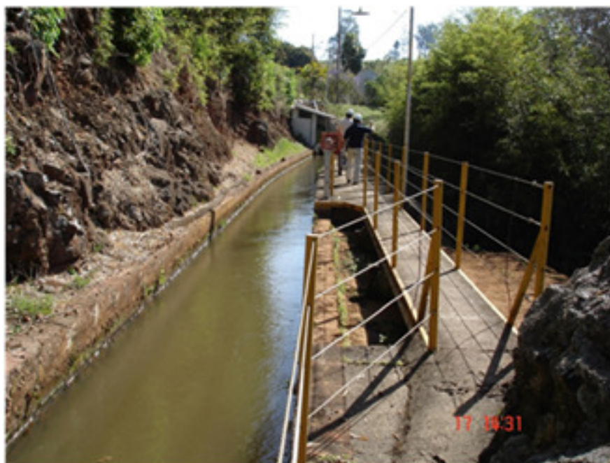
Foto 1.6 – Canal e vertedor de emergência – trecho jusante
