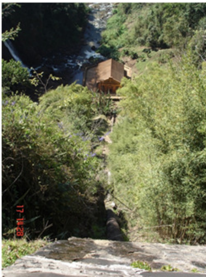
Foto 1.8 – Conduto forçado e casa de força
